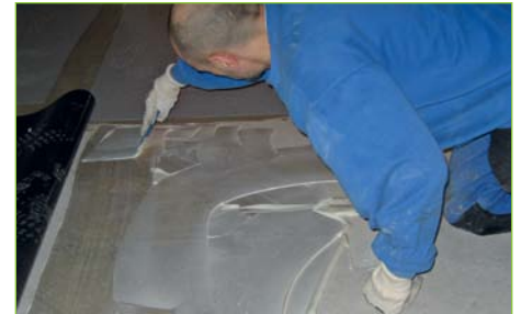
KI 07:30 På oppsparklet underlag påføres Casco Proff Extra (heftlim) (Toppmembran)
