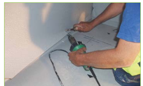
KI 10:45 Overgang gulv og vegg sveises. På nedstøpt membran legges glidesjikt/membranbeskyttelse før påstøp.
