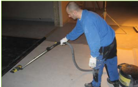
KI 07:00 Stabilt tørt underlag rengjøres, evt. filt legges ut i løsning som skal støpes ned
