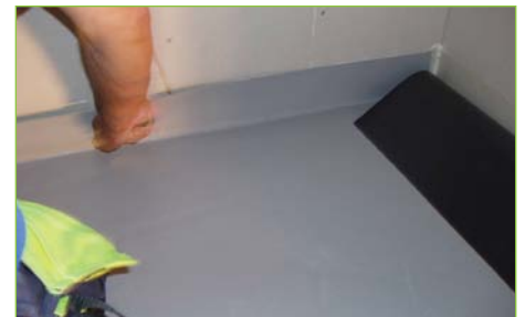
KI 08:15 Tilpasses mot vegger, alle hjørner og detaljer sveises
