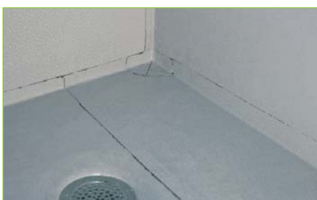
KI 11:00 Samme dag! På toppmembran er hele våtrommet klart for flislegging
