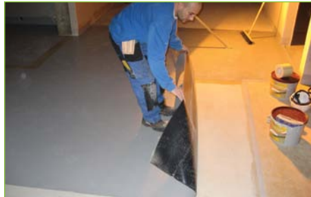
KI 07:15 Membranen tilpasses arealet/ innretning av membran
