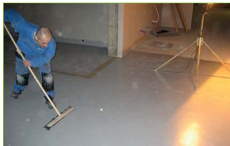
KI 08:00 Membranen utjevnes/ luftblærer må fjernes for å oppnå full kontakt (Toppmembran)
